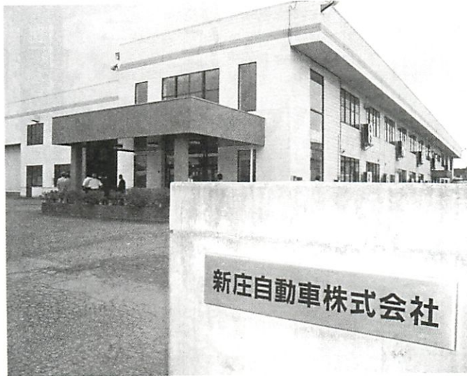
広大な敷地を有する新庄自動車の新工場
